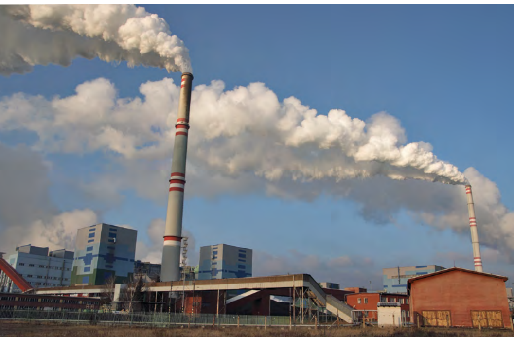
Vue des cheminées d'une usine de production d'électricité au charbon. © DANICEK, FOTOLIA
