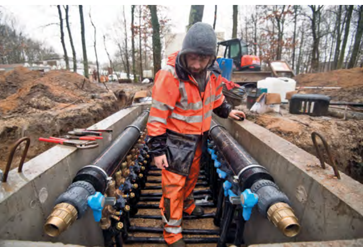
Réalisation d'un champ de 13 forages géothermiques de 100 m de profondeur sur la plate-forme Géothermie du BRGM. © BRGM-ADEME - DIDIER DEPOORTER
